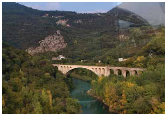
Pogled z Osimske ceste na najlepši železniški most v Sloveniji, Solskanski most.
